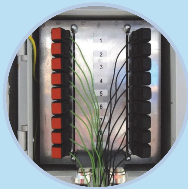
Prüfverdrahtung mit Sicherheits-Schnelldruckklemmen Test leads with safety quick-release terminals
